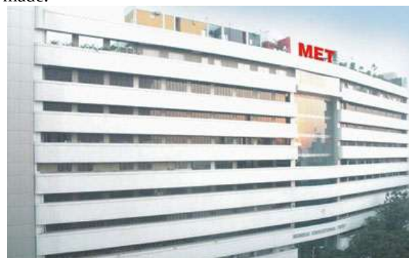
Fig. 4. The MET building
